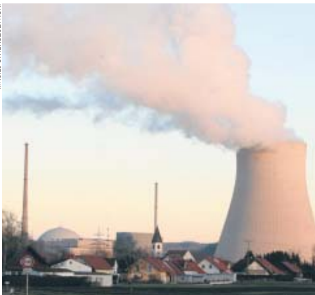
Elektrownia jądrowa w Niederaichbach w Bawarii
